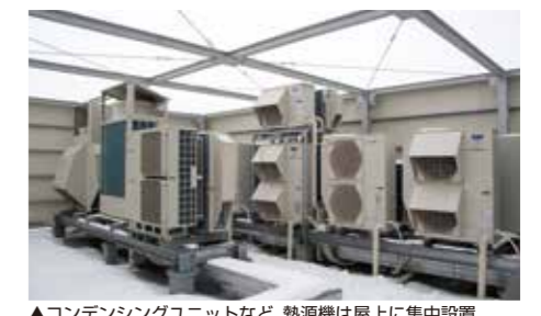
▲コンデンシングユニットなど、熱源機は屋上に集中設置
